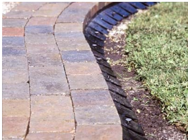
Bild 44: Randabschluss mit PAVE EDGE Randschienen
