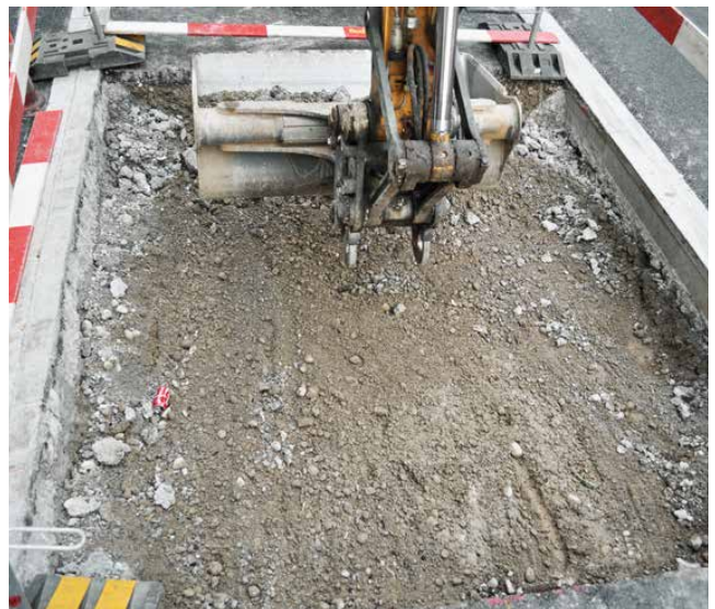
Erstellen der Sohle für den Fundamentrahmen
