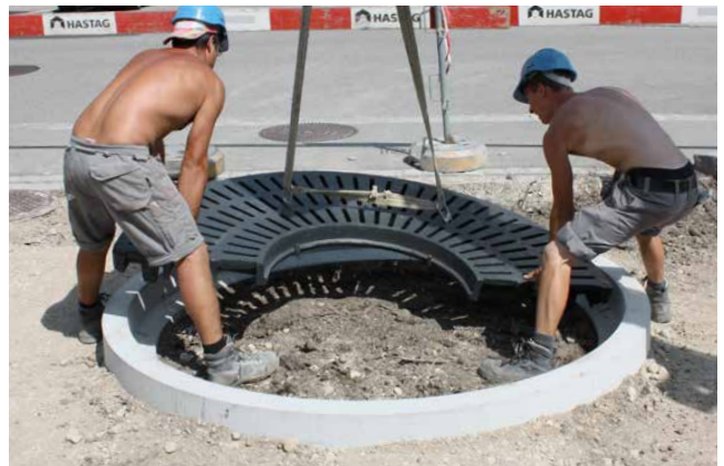
Versetzen der Gussrost
