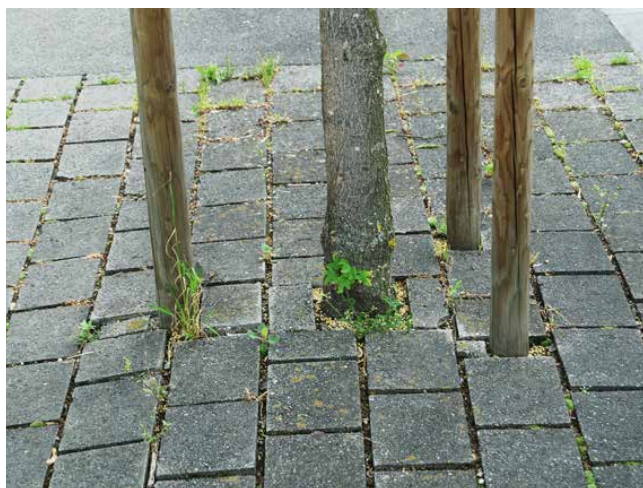
Platzmangel durch Versiegelung der Fläche bis zum Baumstamm
