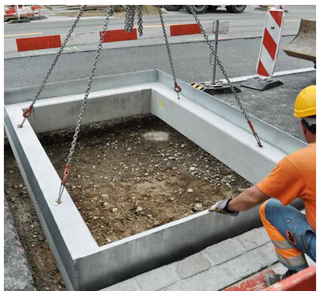
Versetzen des BAUMFIX® Kombirahmenelementes
