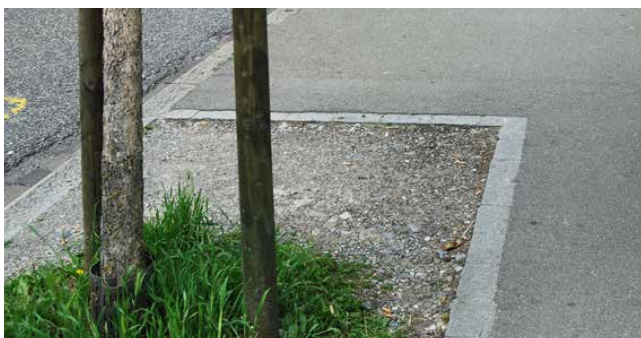
Ungeschützter Wurzelraum führt zu hoher Bodenverdichtung
