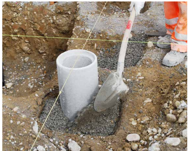
Erstellen der Punktaulager mit Betonrohren
