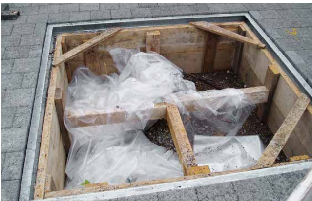
Eingebauter Stahlrahmen als Baumkranz
