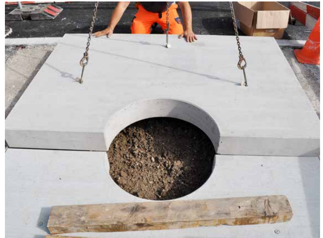
Versetzen der BAUMFIX® Baumscheiben
