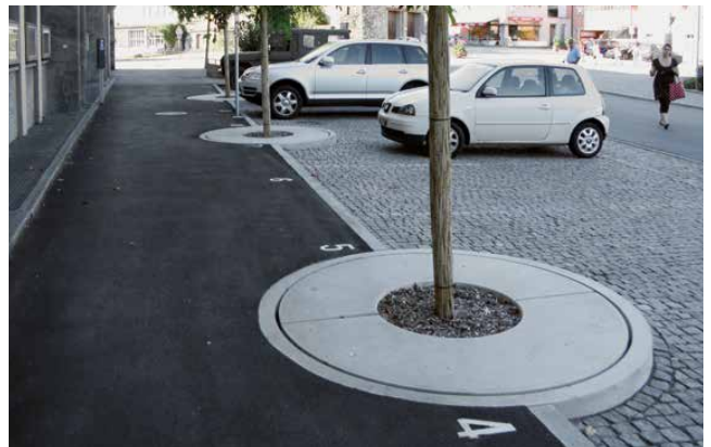
Anlegen von Hochborden
