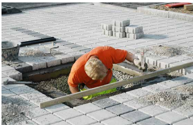
Erstellen eines Auflagers auf Fundamentrahmen
