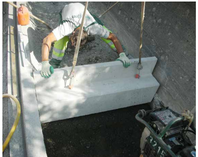
Versetzen des F+F Fertigfundamentes
