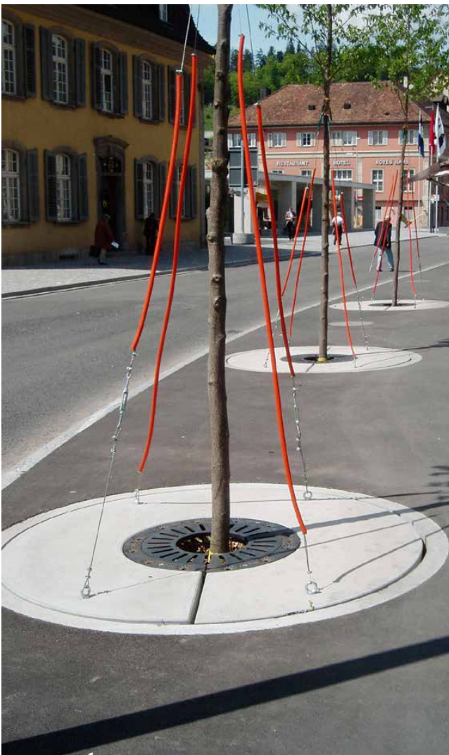
COPAL® CUPOLA Baumwurzelraumschutz mit Gusseinsatz
