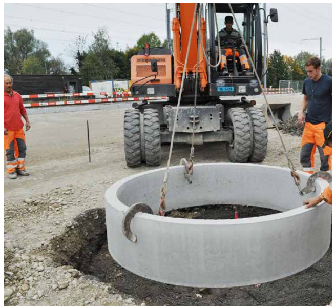
Versetzen des TREETUB Betonrohres auf das Streifenfundament
