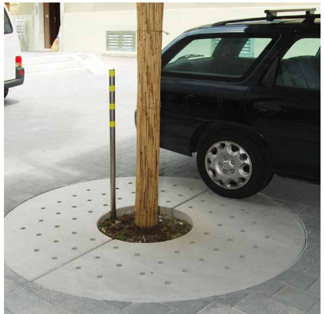
TREETUB Baumwurzelraumschutz mit Betonabdeckung
