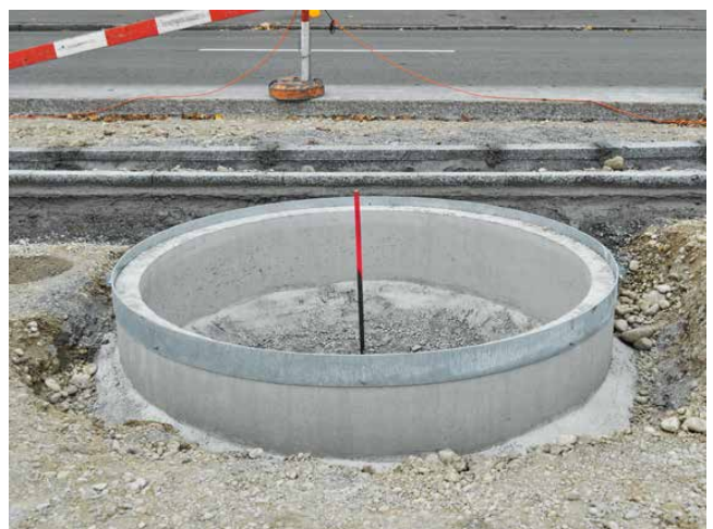
Montierter Stahleinbaurahmen mit Bolzenanker
