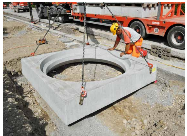
Versetzen des COPAL® QUADRO Basiselementes
