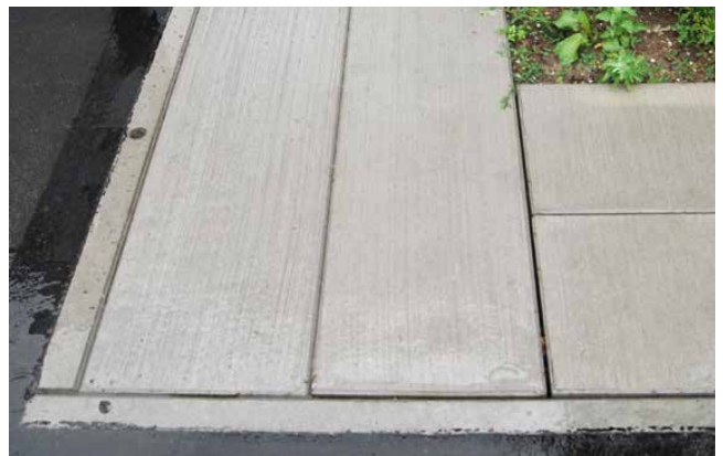
Wasserzufuhr durch Fugen
