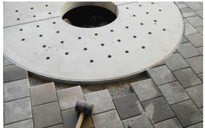
Versetzte TREETUB Betonabdeckung 2-teilig
