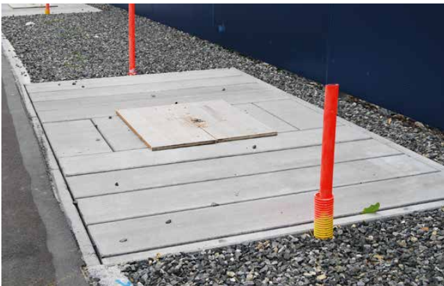
Einbau von Bewässerungs- und Belüftungsleitungen
