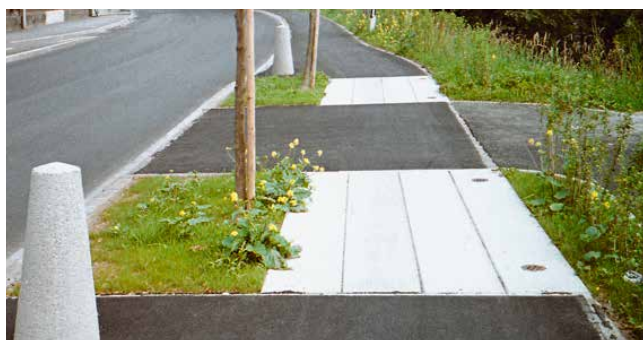
Wurzelbrücke mit Wehrsteinen als Anfahrtschutz
