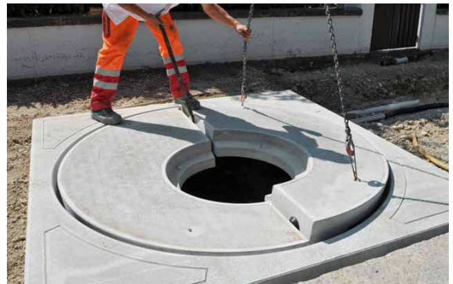
Versetzen der COPAL® Betonabdeckung
