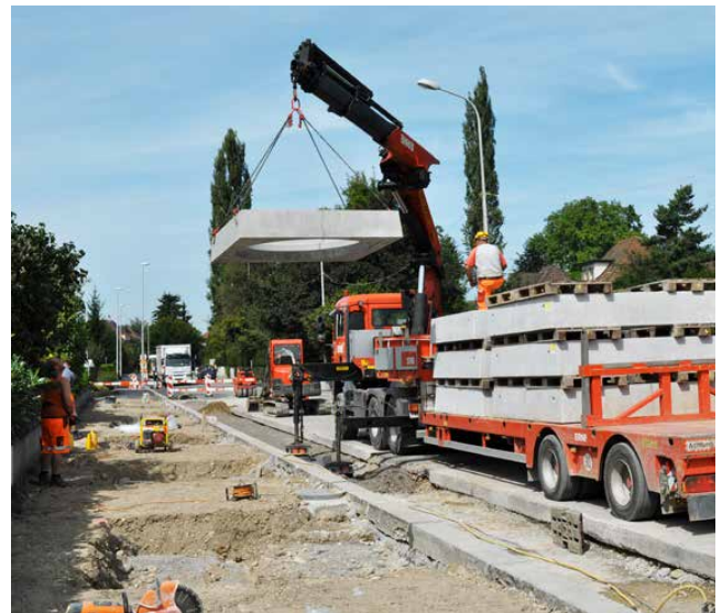
Transport auf der Baustelle mit Lieferfahrzeug
