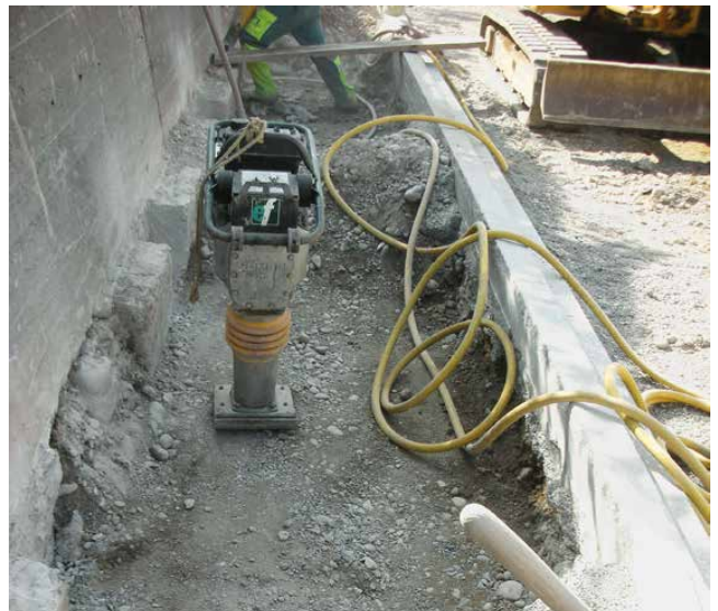
Sohle für die Versetzung der Fundamente
