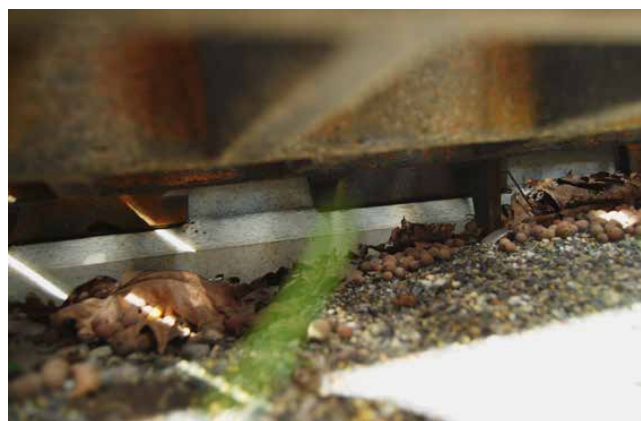
Genügender Zwischenraum unter der Abdeckung
