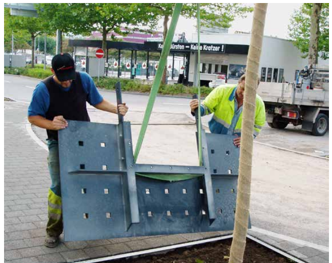
Transport der COPAL® STEEL Stahlbaumscheibe
