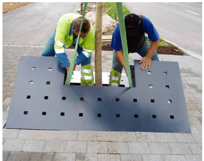
Versetzen der COPAL® STEEL Stahlbaumscheibe
