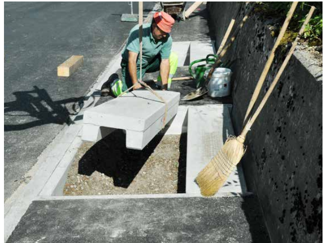
Versetzen der F+F Abdeckelemente
