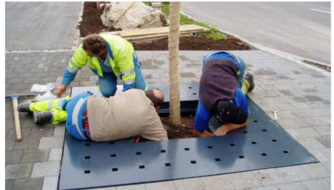
Montieren der Verbindungsschrauben
