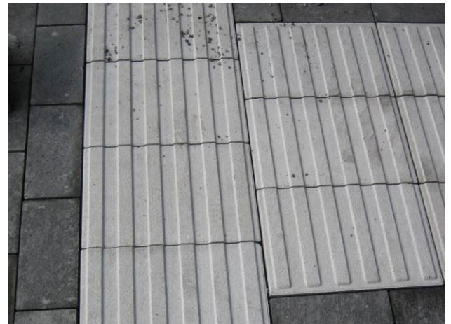
Bild 34: Optimale Fugen bei Steinen H = 8 cm
