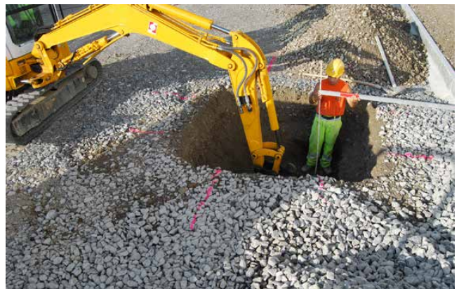
Erstellen des Pflanzloches
