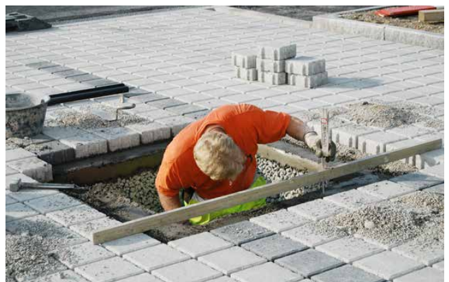
Erstellen eines Auflagers auf Fundamentrahmen
