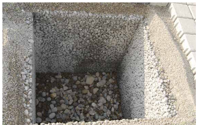
Erstellter Fundamentrahmen
