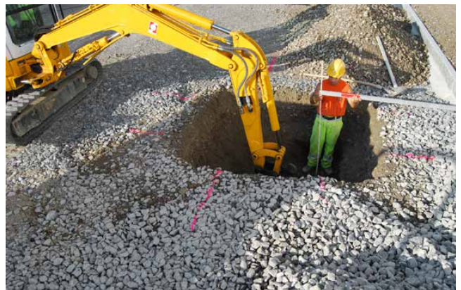
Erstellen des Pflanzloches
