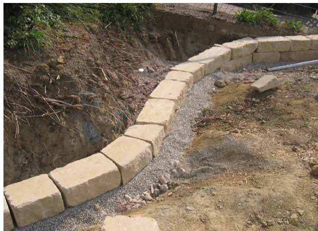
Bild 24: Versetzte erste Steinreihe in Kiesfundament
