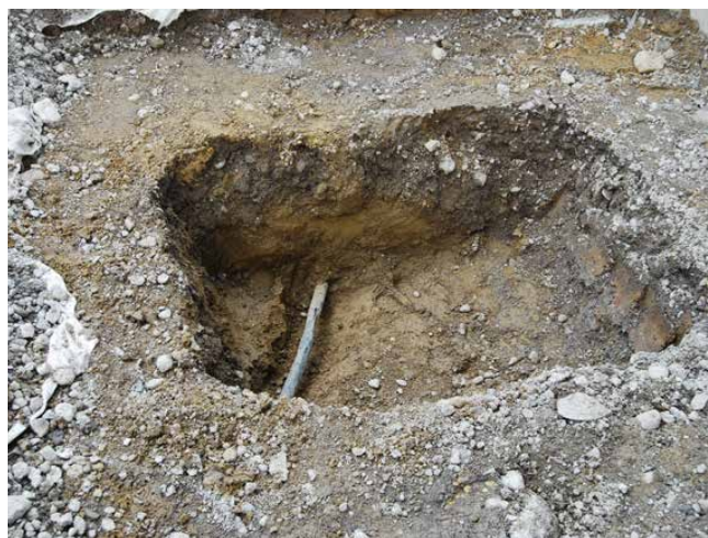
Werkleitungen stören das Wachstum der Baumwurzel
