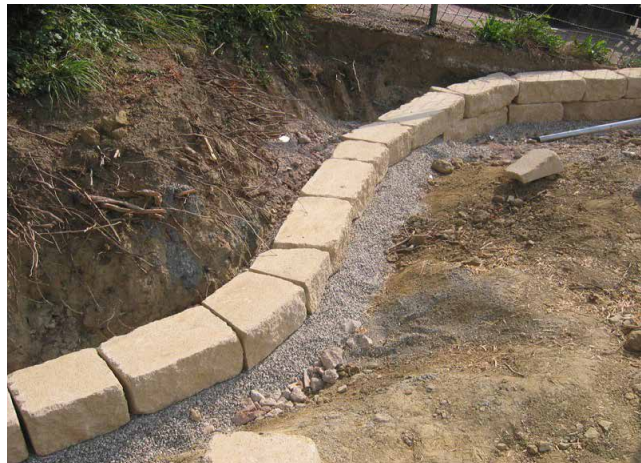
Bild 24: Versetzte erste Steinreihe in Kiesfundament
