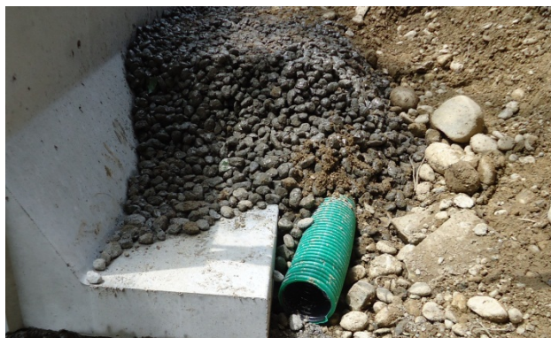
Bild 34: Einbau einer Sickerleitung
