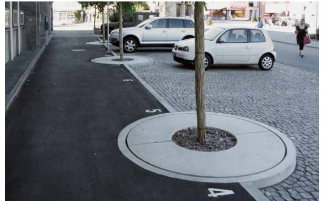
Anlegen von Hochborden
