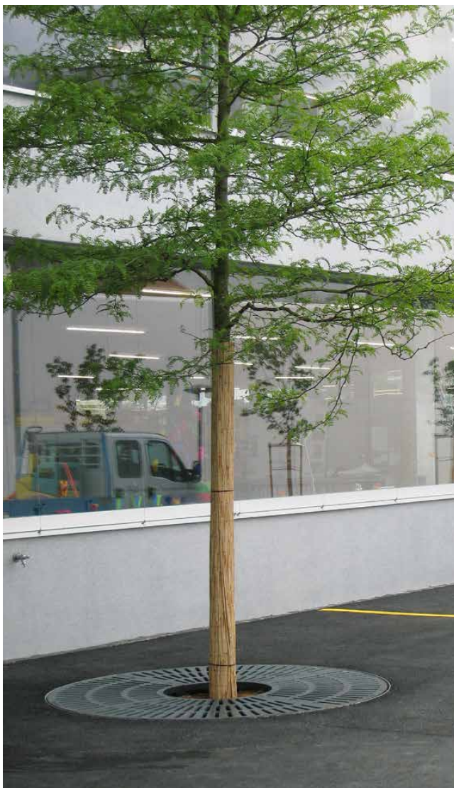
TREETUB Baumwurzelraumschutz mit Gussrost
