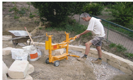
Bild 35: Arbeiten mit Steinspalter
