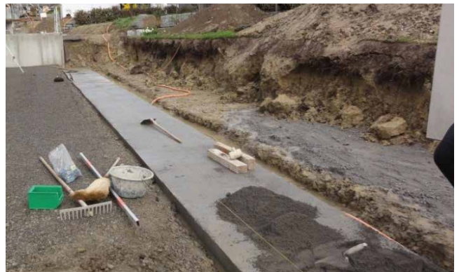
Bild 27: Erstelltes Streifenfundament
