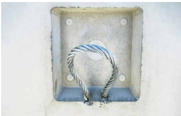
Bild 24: Werkseitig eingebaute Versetzschlaufen
