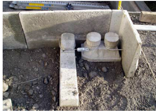
Bild 26a: Eckspanner parallel zum kleineren Schenkel montieren
