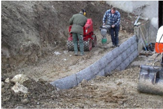
Bild 26: Verdichten der weiteren Schichten
