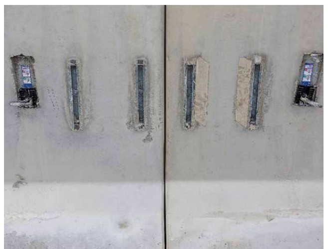
Halfenschienen als Verbindungsgrundlage
