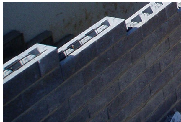
Bild 49: Bewehrungseinlagen, eingelegt in die vorgesehene Nuten
