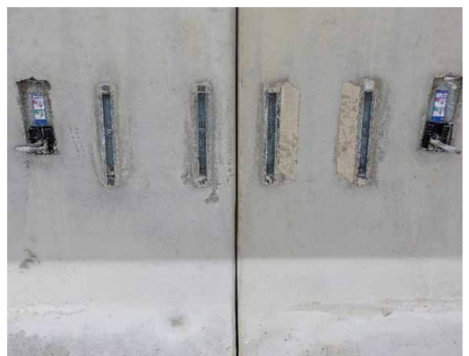
Halfenschienen als Verbindungsgrundlage
