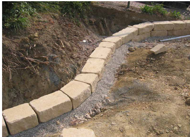
Bild 24: Versetzte erste Steinreihe in Kiesfundament
