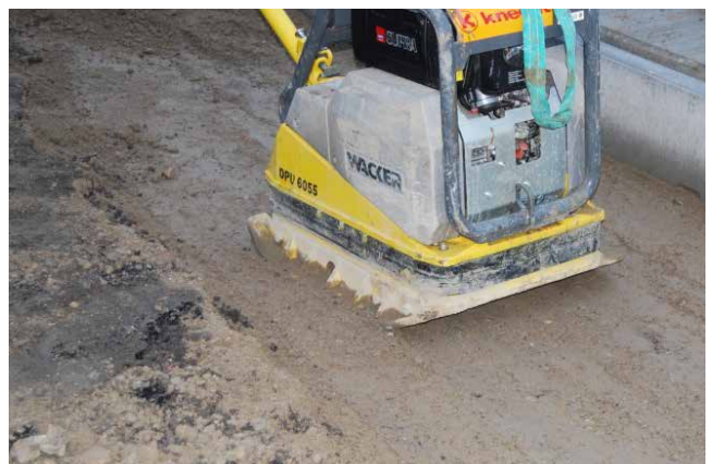
Bild 35: Verdichten nur mit leichten Verdichtungsgeräten
