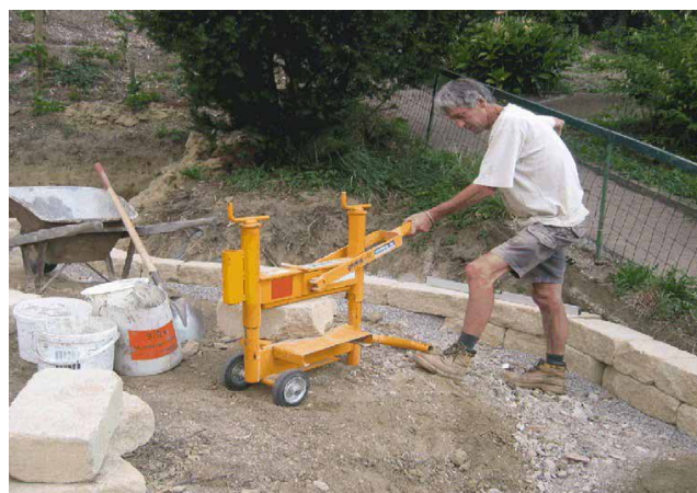
Bild 35: Arbeiten mit Steinspalter
