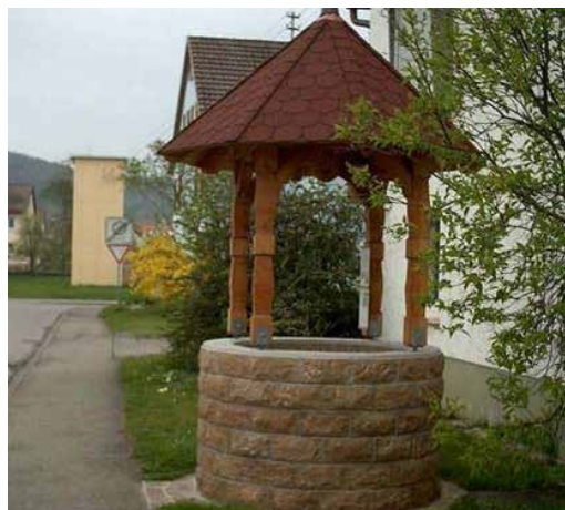
Bild 32: Brunnenbau mit SANTURO® Keilmauersteinen
