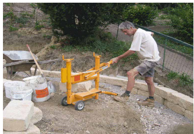
Bild 35: Arbeiten mit Steinspalter
