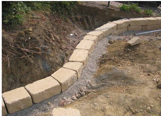
Bild 24: Versetzte erste Steinreihe in Kiesfundament
