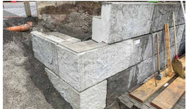
Bild 24 Versetzen der Eckelemente
