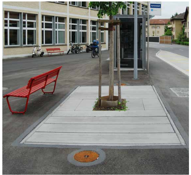
F+F Baumwurzelraumschutz, anthrazit eingefärbt
