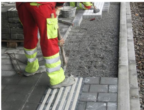
Bild 32: Herausnehmen der restlichen Steine
