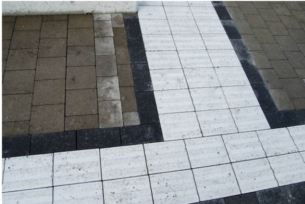
Bild 35: Optimale Fugen bei Steinen H = 6 cm
