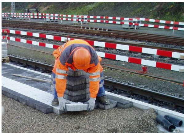
Bild 26: Verlegen von CARENA® Sicherheitsliniensteine H = 8 cm
