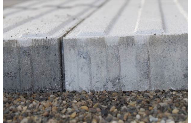
Bild 37: Verlegte CARENA® Sicherheitsliniensteine H = 6 cm
