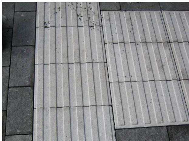
Bild 34: Optimale Fugen bei Steinen H = 8 cm
