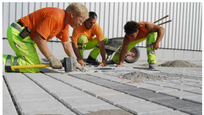
Versetzen der COMO Baumscheiben
