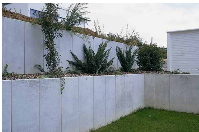
Bild 1: EXACTA® Winkelplatten als Böschungssicherung
