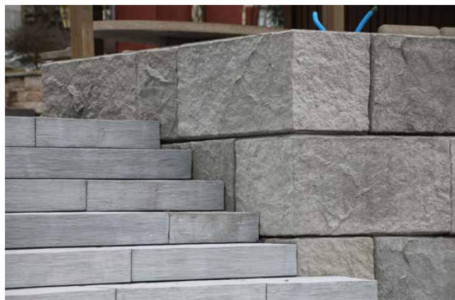
Bild 2 FELDMAUER Böschungselemente als Böschungssicherung
