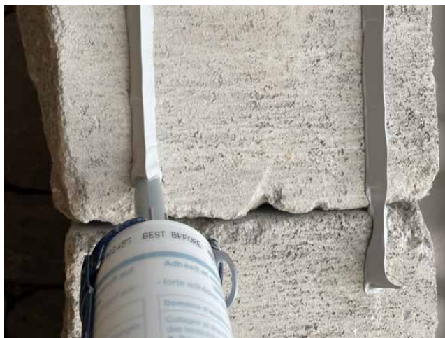
Bild 3: Korrekte Ausrichtung der Düse
