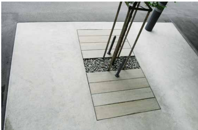
Einbau von Baumgruben mit einer Fläche von > 6 m 2
