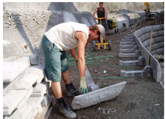
Bild 16: Frontplatte mit Anker verbinden
