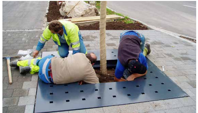
Montieren der Verbindungsschrauben
