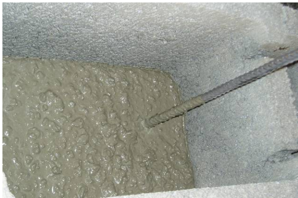
Bild 51: Füllhöhe bei der obersten Lage pro Betonieretappe
