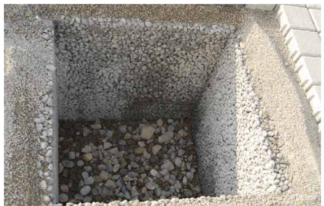
Erstellter Fundamentrahmen
