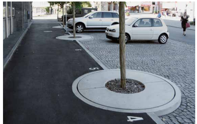
Anlegen von Hochborden
