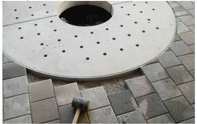
Versetzte TREETUB Betonabdeckung 2-teilig
