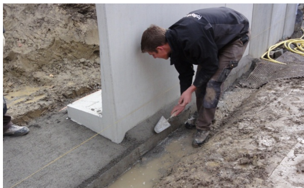
Bild 37: Erstellen der Fundamentnocken
