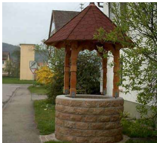
Bild 32: Brunnenbau mit SANTURO® Keilmauersteinen
