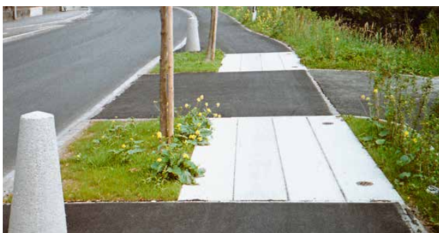
Wurzelbrücke mit Wehrsteinen als Anfahrtschutz
