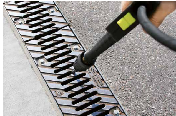
Bild 12: Reinigungsdüse BIRCOeasyclean
