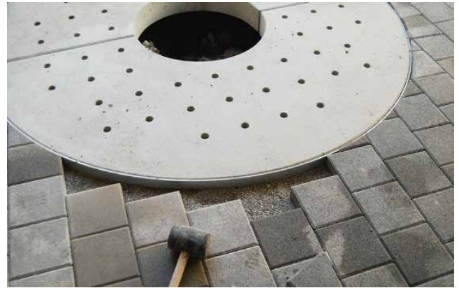
Versetzte TREETUB Betonabdeckung 2-teilig
