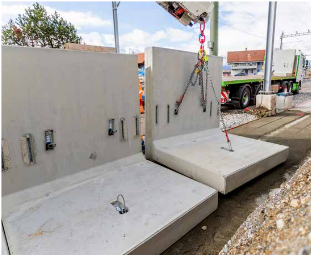
Werkseitig eingebaute Seilschlaufen
