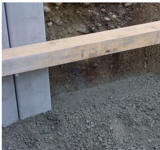
Bild 7: Vorbereitete Sohle mit Richtlatte
