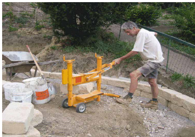
Bild 35: Arbeiten mit Steinspalter
