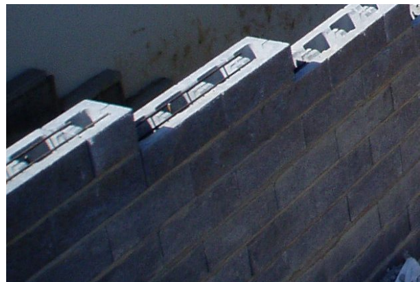
Bild 49: Bewehrungseinlagen, eingelegt in die vorgesehene Nuten
