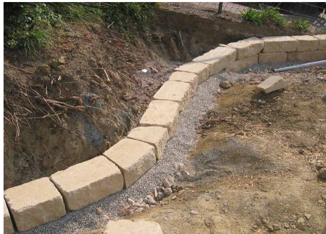
Bild 24: Versetzte erste Steinreihe in Kiesfundament
