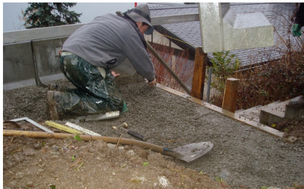
Bild 21: Erstellen des Streifenfundamentes
