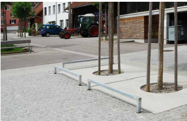
Montierte Radabweiser
