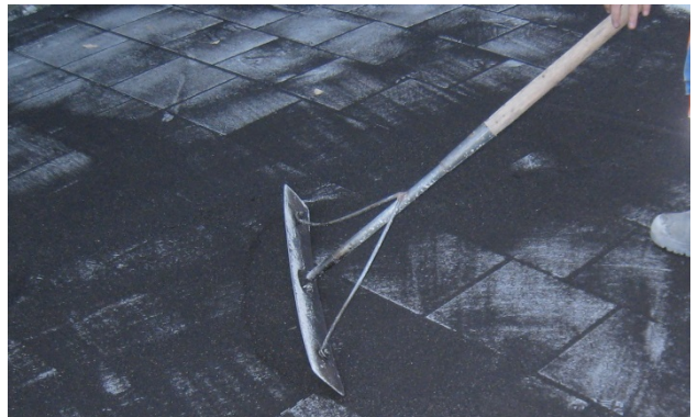
Bild 28: Einbringen des Fugenmaterials von Hand
