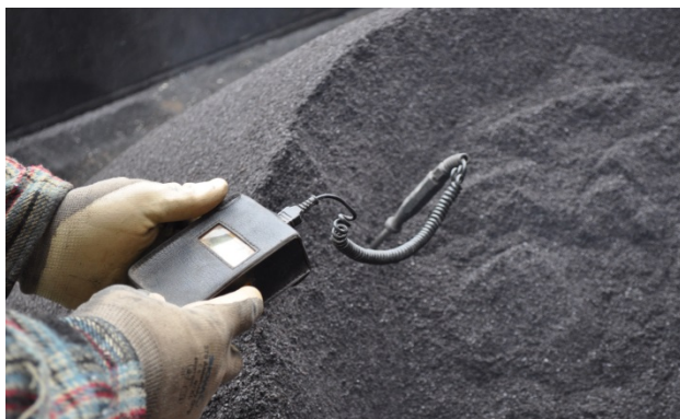
Bild 20: Kontrolle der Einbautemperatur
