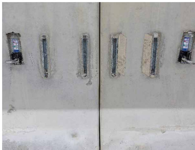
Halfenschienen als Verbindungsgrundlage
