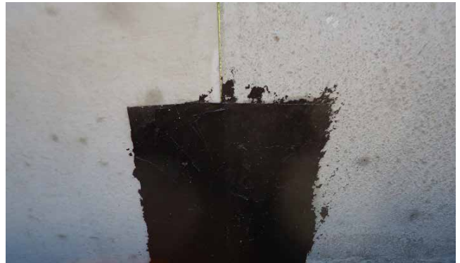
Bild 33: Abdichten der Fugen
