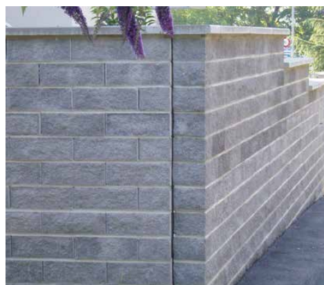
Bild 41: Dilatationsfuge (Produktneutral)
